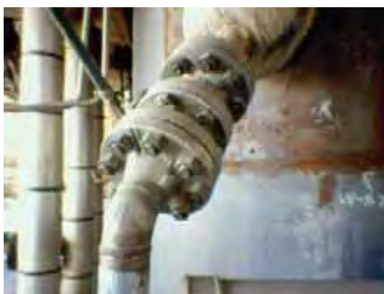
Cette vanne d'isolement CA-DRI classe ASME 300 de 2 po (5,08 cm) est utilisée à la sortie de catalyseur usé chaud du régénérateur.
