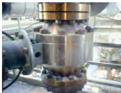
Cette vanne d'isolement CA-DRI classe ASME 300 de 8 po (20,32 cm) fonctionne sur un catalyseur à 1425° F (774° C) depuis de nombreuses années. Il s'agit de la vanne la plus importante pour l'isolement du séparateur à cyclone entre la troisième et la quatrième niveau.
