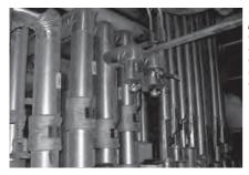
Ce modèle de vannes RSVP de MOGAS permet d'assurer une meilleure évacuation de la vapeur principale, que les robinets à soupape utilisés précédemment. Avec des conditions de service de 950 °F à 1875 psi (510 °C à 129 bar), la fiabilité de ces vannes est un élément essentiel.
