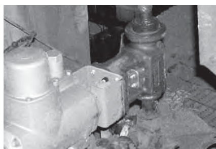
Cette vanne de décharge type RSVP ASME Classe 4500 a été conçue pour supporter les pressions et les températures extrêmement élevées provenant de la chaudière.
