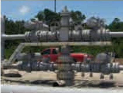
*Ces vannes FlexStream sont installées dans une unité de stockage de gaz (caverne de sel). Ces vannes ont la capacité unique de réguler la baisse de pression en phases de remplissage comme de soutirage.*
