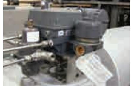
*Le positionneur intelligent reçoit les informations du changement de position de de la vanne. Cela permet à l'instrument de diagnostiquer la vanne et l'actionneur sur lesquels il est monté, fournissant ainsi des informations précieuses pour la maintenance préventive.*
