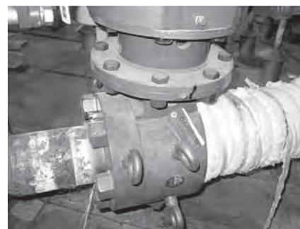
La vanne type C a été retenue pour le système de purge de chaudière de notre client en raison de sa rapidité de fonctionnement avec un actionneur quart de tour, et sa parfaite étanchéité. Ces photos ont été prise lors d'une opération de maintenance préventive, alors qu'une partie de l'installation avait été retirée.
